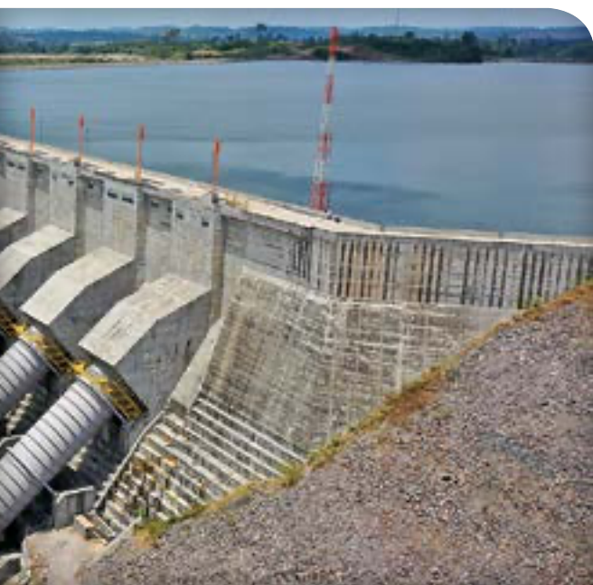
Usina Hidrelétrica de Belo Monte, na Bacia do Xingu, no norte do estado do Pará.
