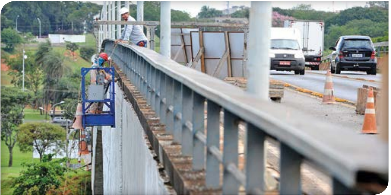
Reforma na estrutura da Ponte Costa e Silva, em Brasília.
